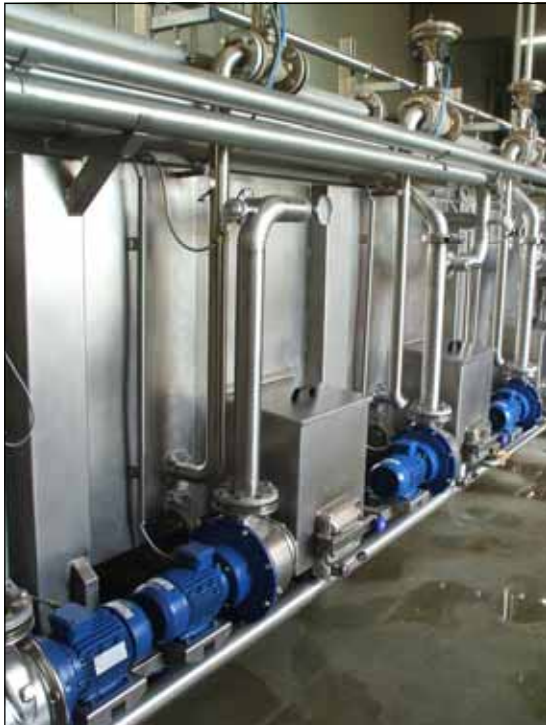
Kreiselpumpen der Baureihe SHS in der Pasteuranlage
